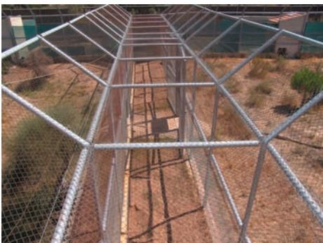
Entre cada dos instalaciones hay un pasillo cubierto con malla metálica de 1,8m de anchura, comunicado con ambos campeos mediante puertas de guillotina que se accionan desde las torretas de vigilancia, lo que posibilita distintos grados de acercamiento entre los animales de dos instalaciones
