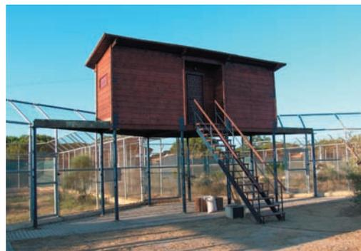
Entre cada dos jaulas de manejo contiguas se alzan unos observatorios de madera de 7m de largo por 3,5m, en su parte más ancha, que se apoyan sobre columnas metálicas, desde los cuales, además de vigilar el comportamiento de los animales, se accionan las puertas de guillotina (acceso de jaula exterior a jaula de manejo, y acceso de jaula exterior a los pasillos de separación). En una de las torretas se centraliza el sistema de video-vigilancia.
