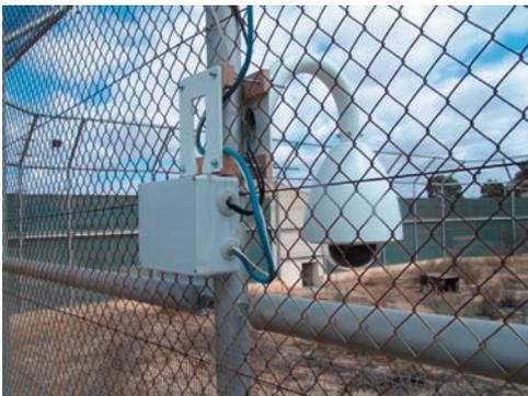
El sistema de video-vigilancia se compone de un total de 24 cámaras, distribuidas entre el recinto de reproductores (20), voladeros (2) y edificio de cuarentena (2). La señal se recibe en el edificio de oficinas en dos video-grabadores digitales en los que se almacena toda la información. Periódicamente, la información se descarga en DVD's para su posterior análisis y conservación.
