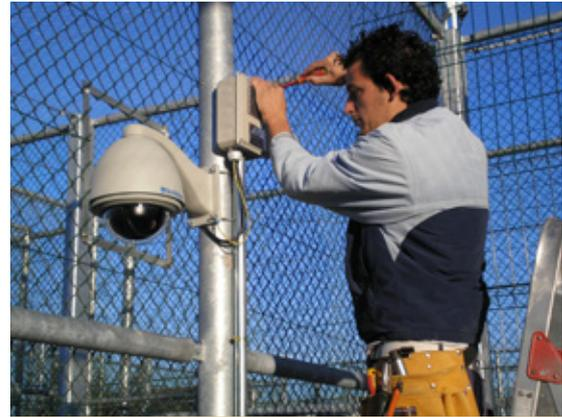
Técnico realizando la instalación de una cámara
