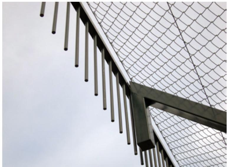
Sistema "peines" anti-fugas instalado en los centros de cría.
